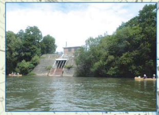
赤間小裏発電所
