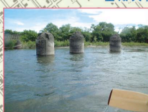
空知大橋旧橋脚
