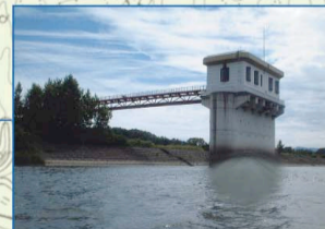
空知川取水塔
