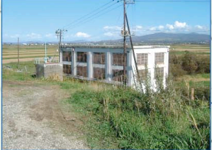
西6丁目排水機場
