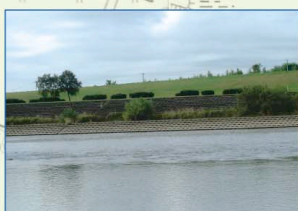
橋本樋門下流護岸
