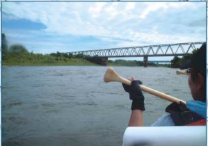
第1空知川橋梁
