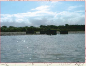
砂川大橋下流旧橋脚
