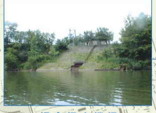
幌倉揚水機場
