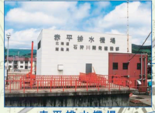
赤平排水機場
