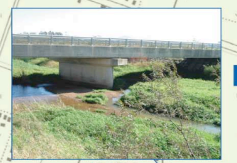
第1熊穴川2号橋
