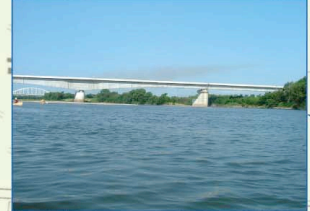
深川大橋 (高速)
