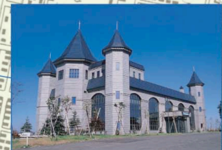
砂川遊水地管理センター (ウォータービルズ)
