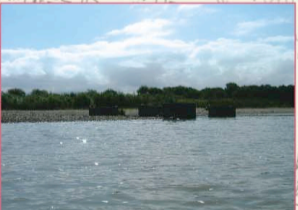
砂川大橋下流旧橋脚
