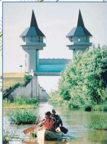
砂川遊水地排水門
